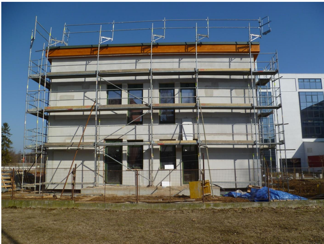
Obrázek č.1 Výstavba odborného školícího střediska
